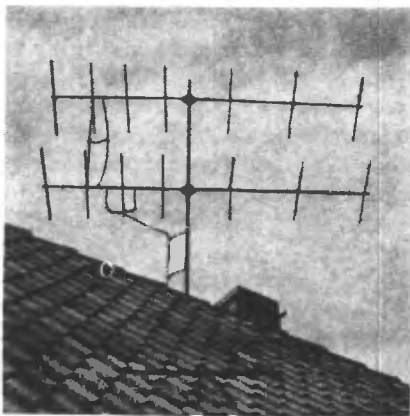
22.23. ábra. A 7/7 elrendezésű kétszintes emeletes hosszú Yagi-antenna DI 6 EK szerint
